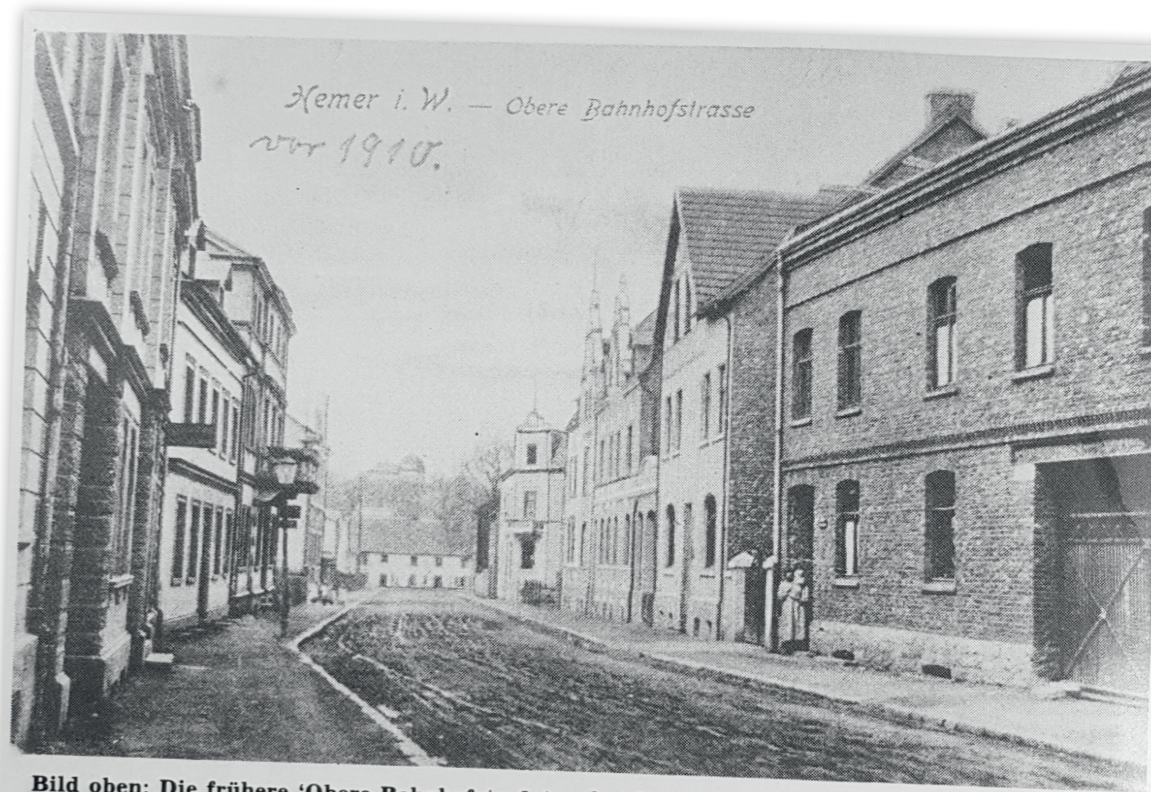
Bild oben: Die frühere 'Obere Bahnhofstraße' - heute 'Friedrich - List - Straße'. Das Bild entstand vor 1910. Vorn rechts stehen noch Werkswohnungen von Becke - Prinz. Von der ganzen rechten Häuserzeile ist inzwischen kein Gebäude mehr übrig geblieben. Ganz unten am Ende der Straße: die einstige 'Hurra-Bude', heute Volksbank. Die 'Hurra-Bude', eine Art städtischer Notunterkunft, wurde abgerissen, und durch eine schöne gärtnerische Anlage vor der Firma Clarfeld & Springmeyer ersetzt. Auch diese Anlage ist inzwischen schon wieder Geschichte. Darüber auf dem Hügel die Kuppel der Wulfertschule - damals Realschule. Es gab neben der 'Oberen Bahnhofstraße' auch eine 'Untere Bahnhofstraße', die heutige 'Stephanstraße'.
